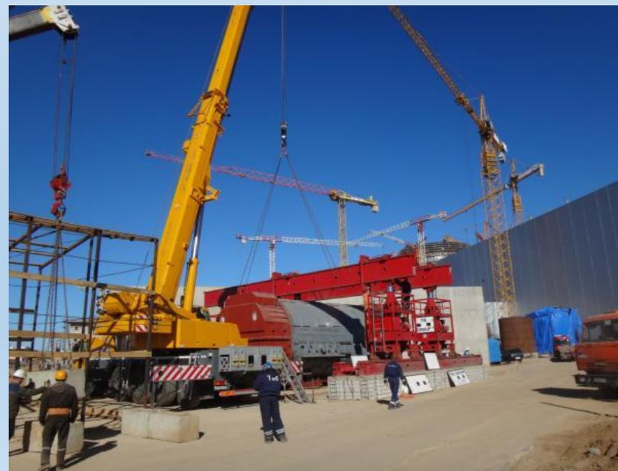
Международная перевозка негабаритного оборудования - установки по производству высокооктановых бензинов в адрес **Антипинского нефтеперерабатывающего завода** по маршруту порт Марина ди Каррара (Италия) - Ростов-на-Дону - г. Тюмень.
